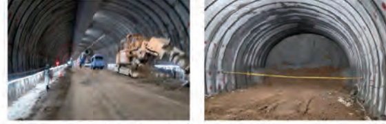
中部縦貫道坊方トンネル工事現場
